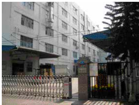
NLE工場L棟東側
